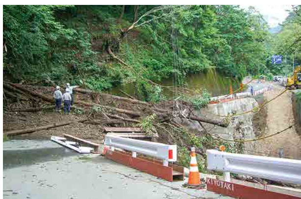
9月の大雨による被害。県道水上片品線柿平バス停付近。
