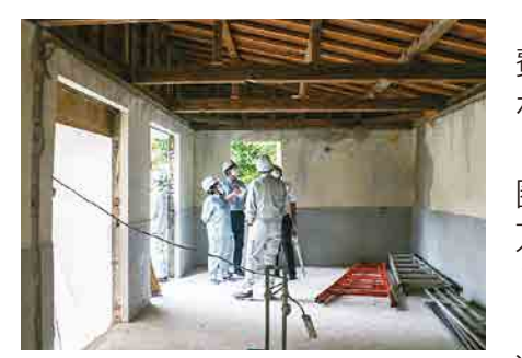
改修工事中の水上火葬場待合室
