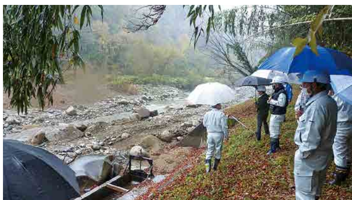
赤谷川氾濫、頭首工復旧工事
