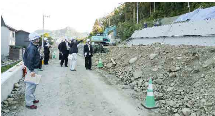
町道悪戸矢瀬線道路改良工事
