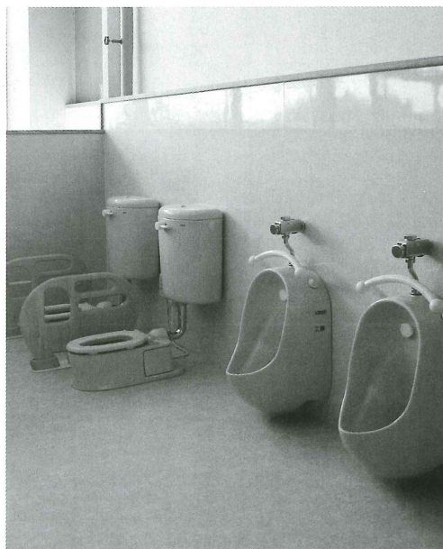
新設されたこども園のトイレ
