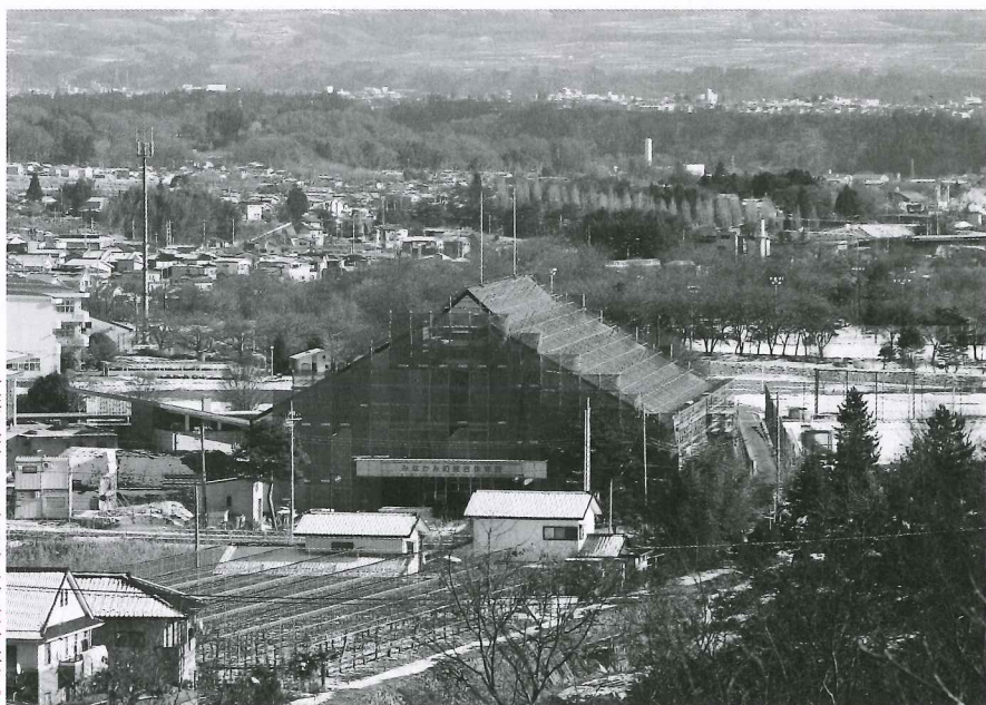
改修工事のみなみ町総合体育館
