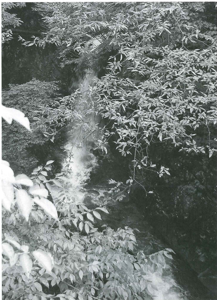
トンネル湧水
