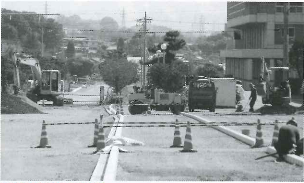
真政悪戸線道路工事現場
