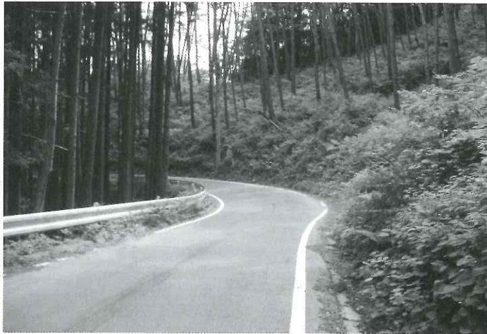
道路の改良が望まれる大道峠
