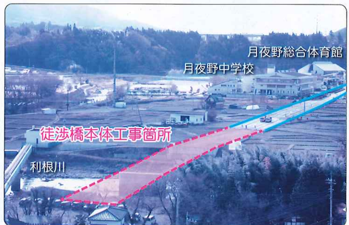
真政悪戸線の利根川に架かる徒渉橋
