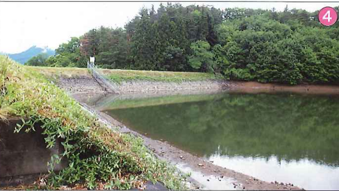
池田溜池（農業用水）についての耐震補強調査
