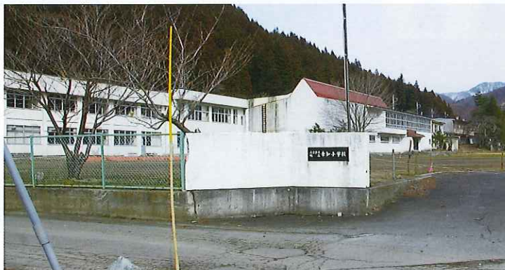
工事契約が結ばれ解体間近の旧幸知小学校
