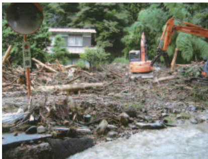
台風9号がもたらした佐用町の被害状況
