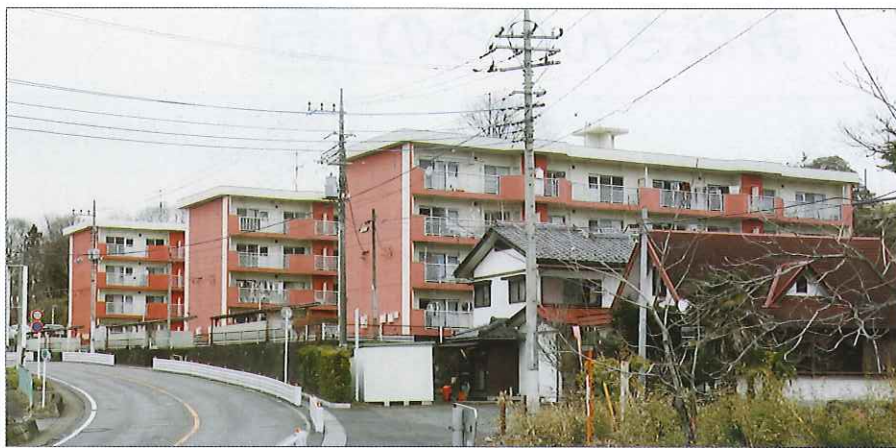
下牧町営住宅
