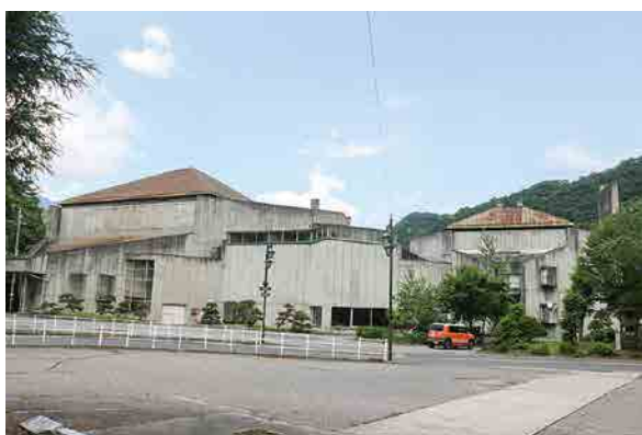
老朽化で使用が制限されている水上観光会館
