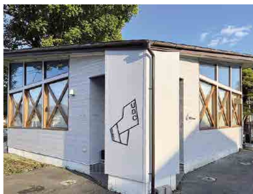
UDCみなかみ（上毛高原駅前）
