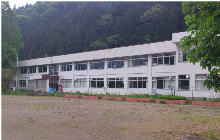
(解体予定の旧幸知小学校)
